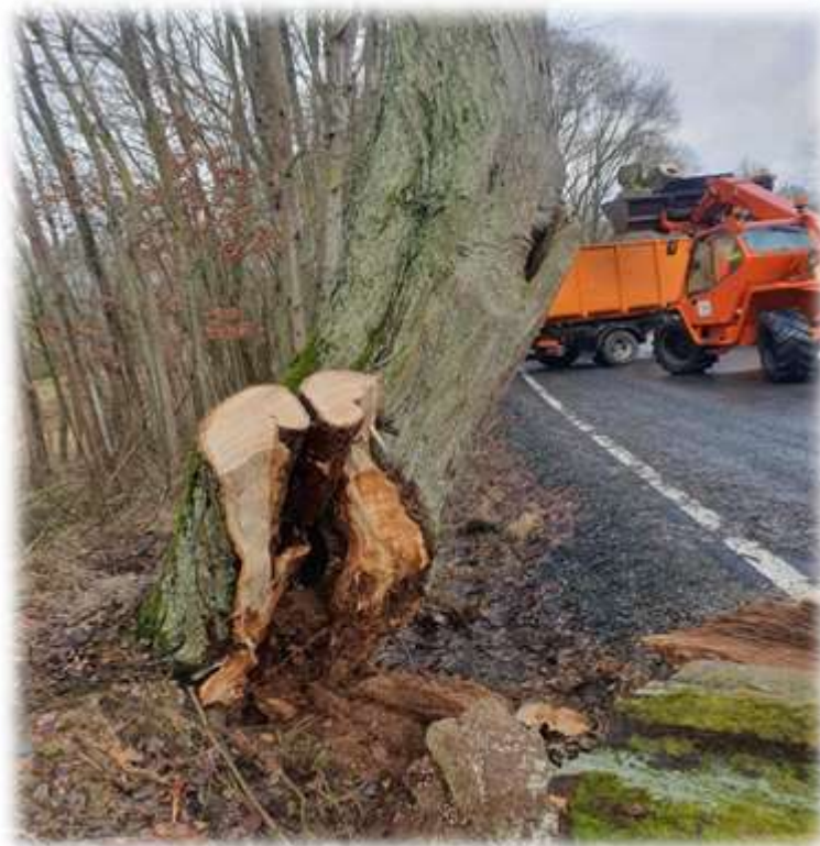
Stř. 57 kácí havarijní lípu u silnice III/19511 u obce Mutěšín
