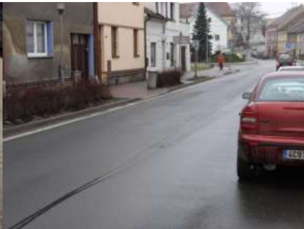
Po ukončení realizace:
