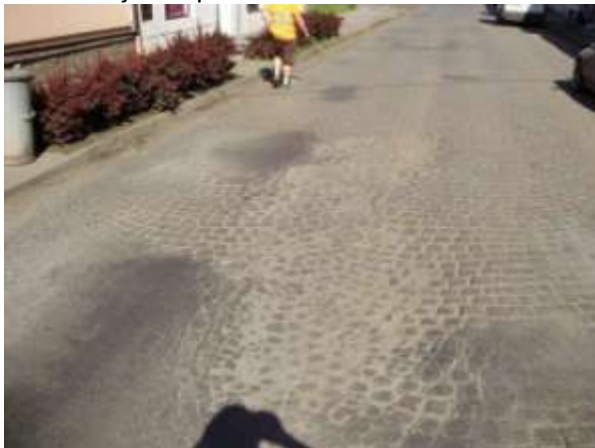
Před zahájením prací:
