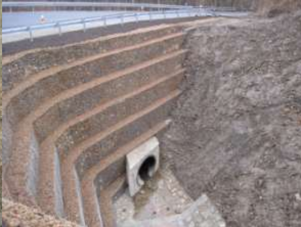
Po ukončení realizace:
