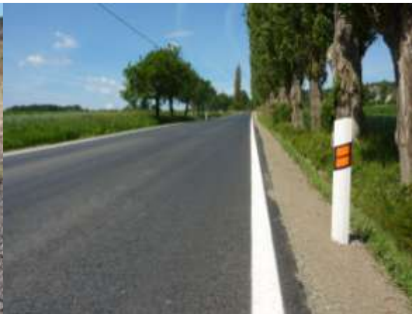
Po ukončení realizace:
