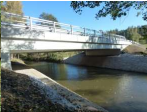
Po ukončení realizace:
