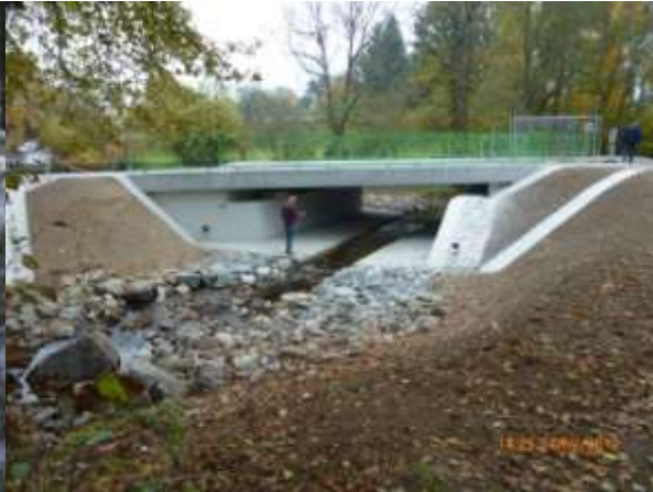
Po ukončení realizace:
