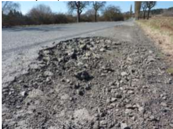
Před zahájením prací:
