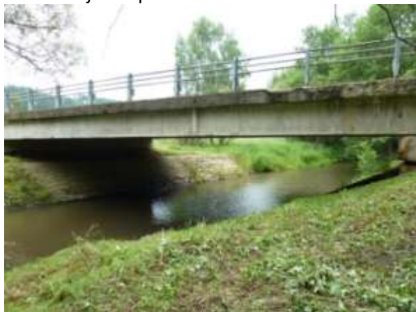
Před zahájením prací:
