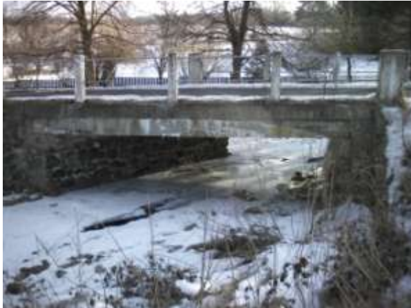
Před zahájením prací:
