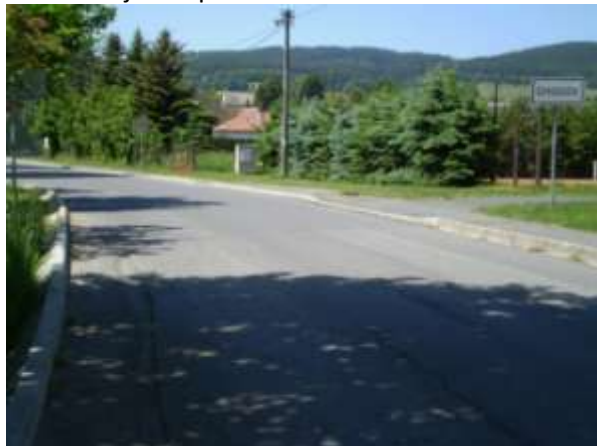
Před zahájením prací:
