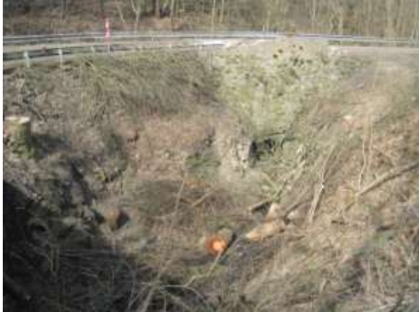
Před zahájením prací:
