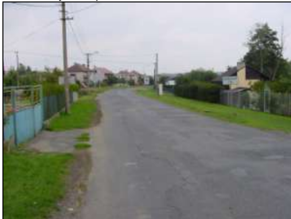
Před zahájením prací:
