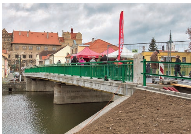
Pohled na most s historickým centrem v pozadí
