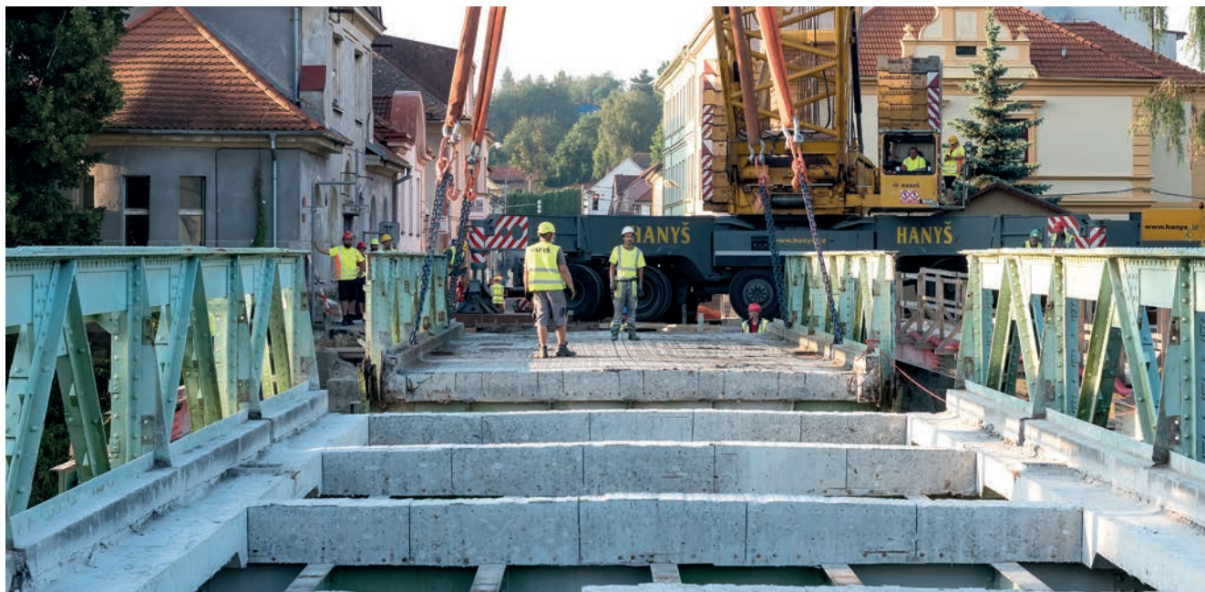
Odhalená konstrukce mostu při demontáži
