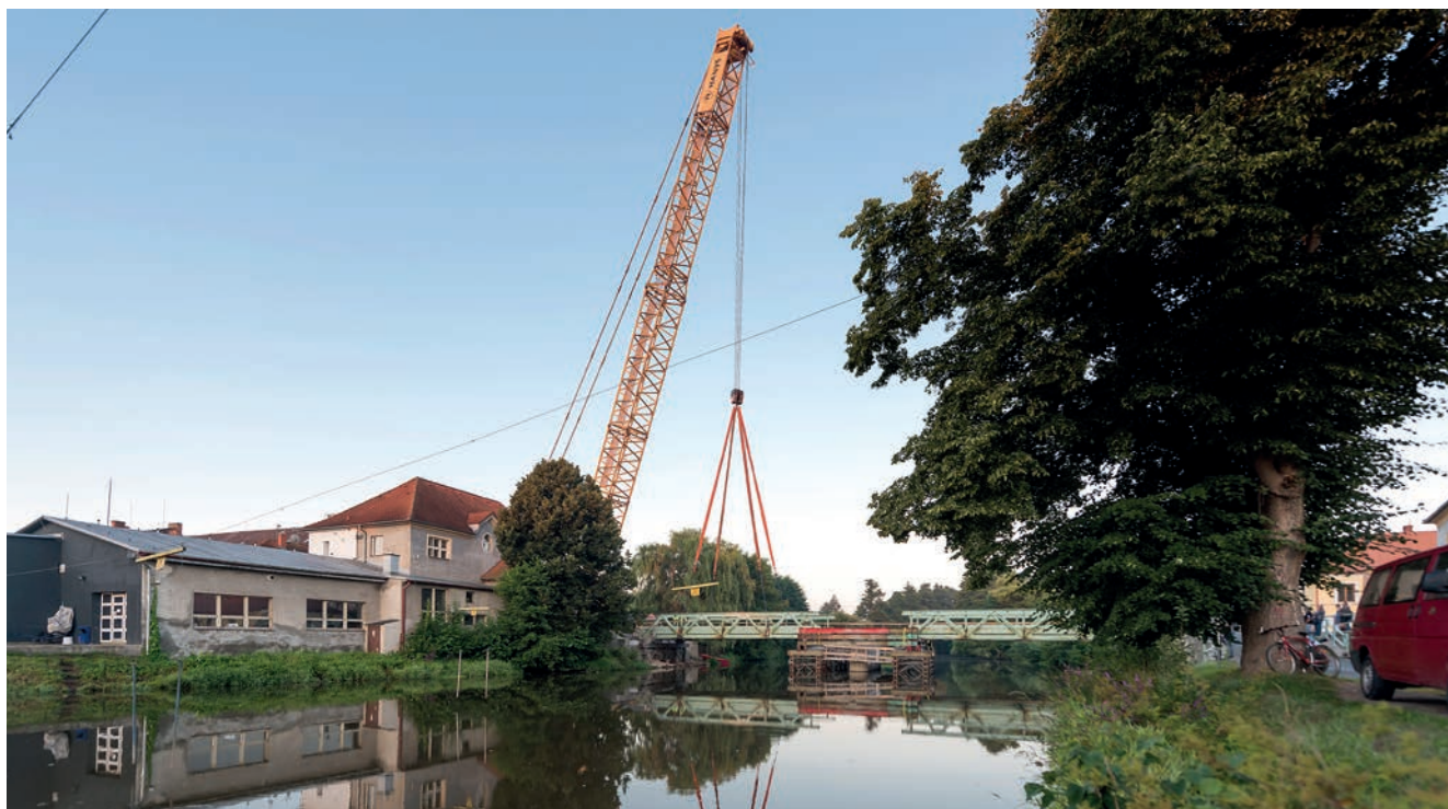
Náročná demolice ocelové konstrukce
