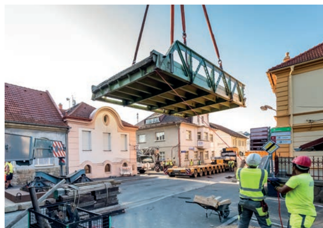
Demontáž a výměna za nový most trvala jen tři dny
