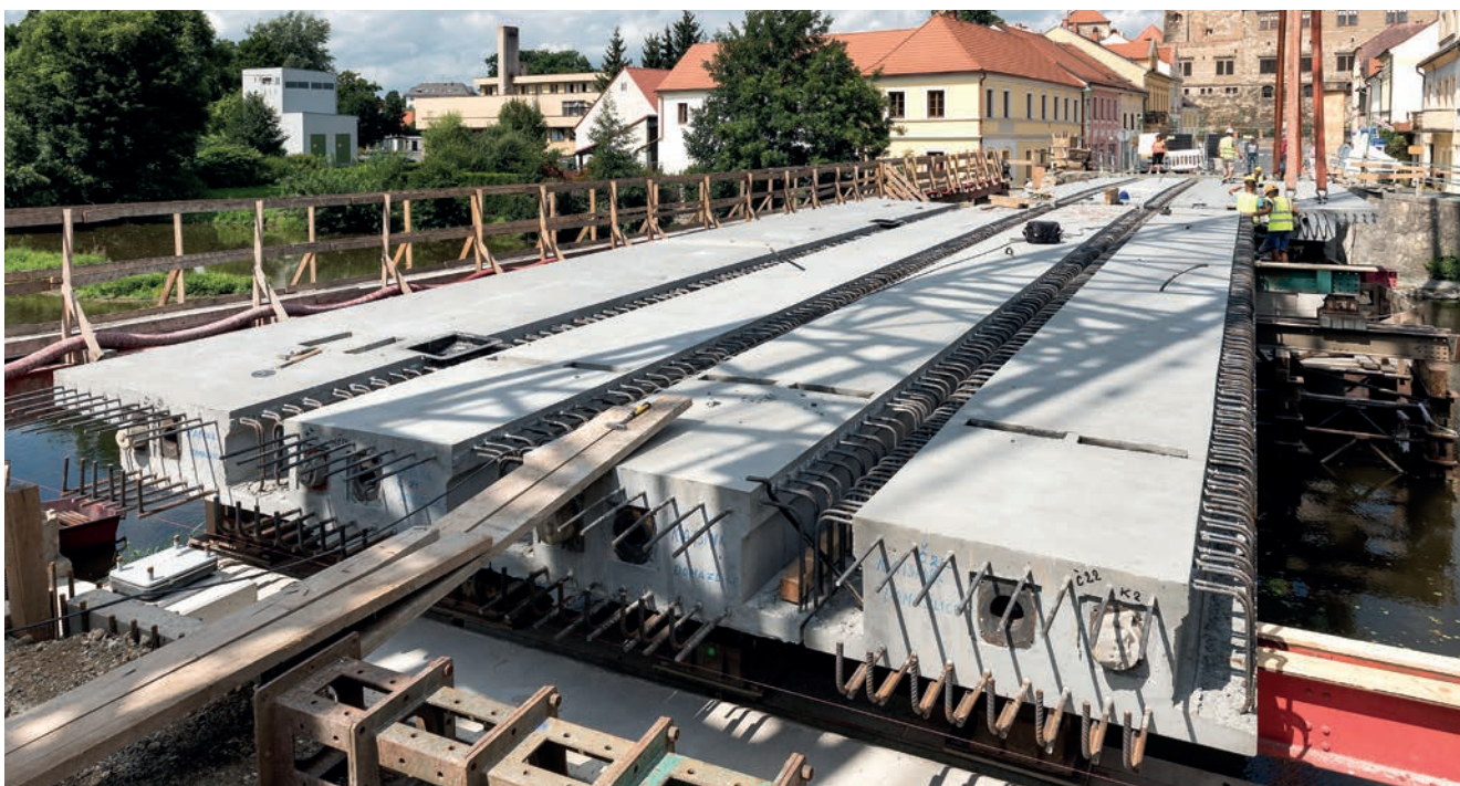
Instalace nových železobetonových nosníků
