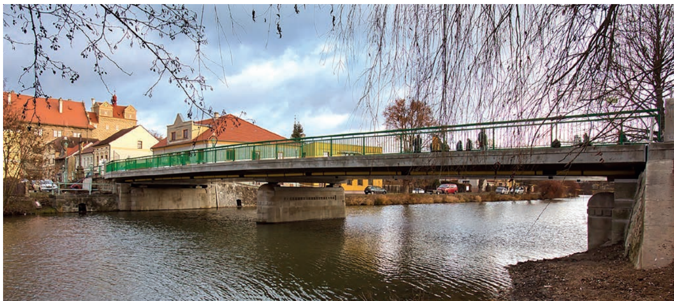
Pohled na nový most v Horšovském Týně
