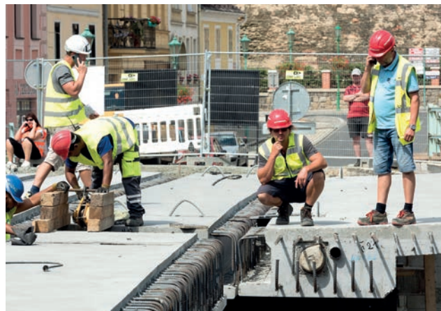
Stavba proběhla v kompletní uzavěře dopravy
